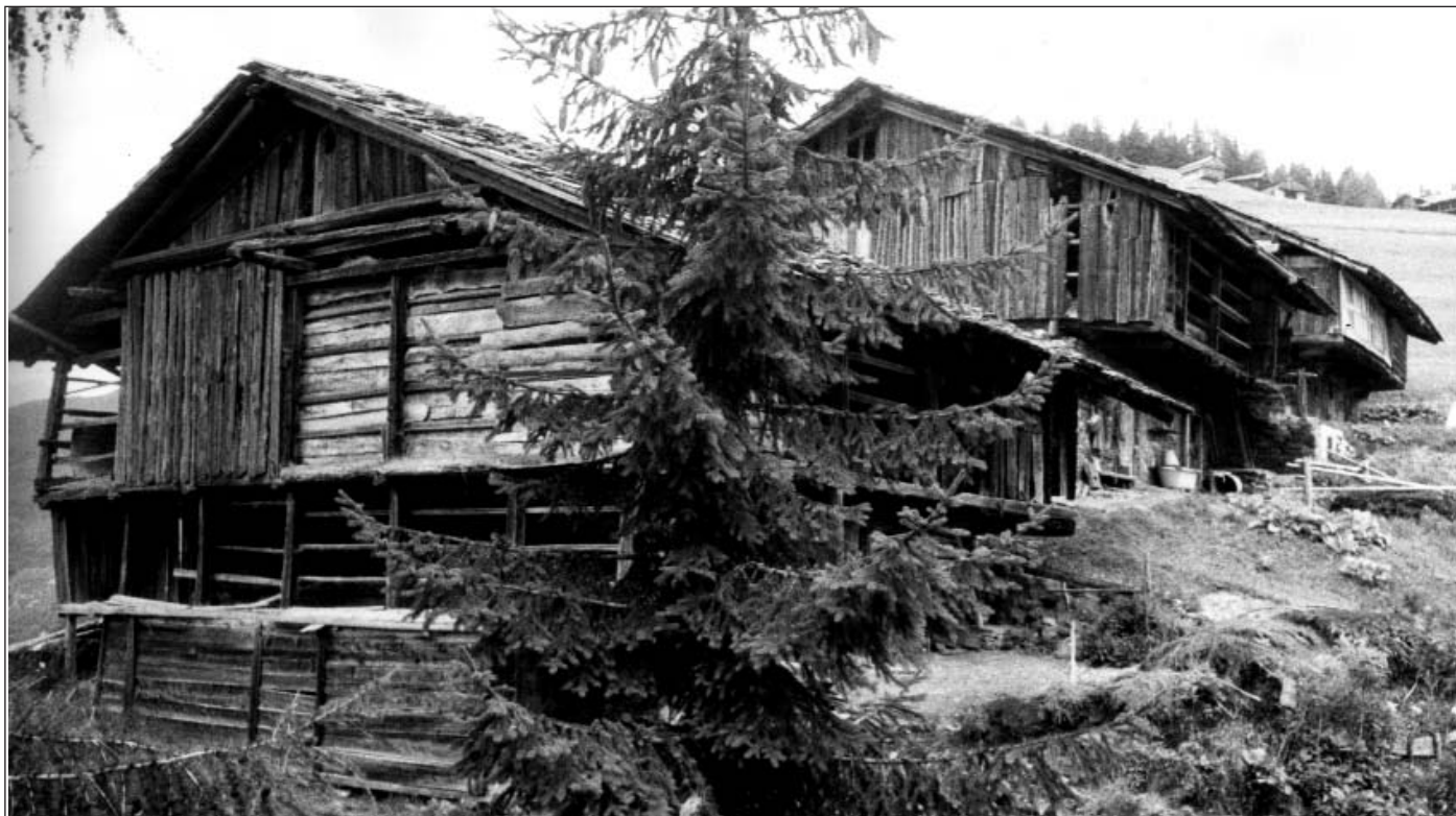
Antichi tabiadas in località San Leonardo distrutti da un incendio l'8 febbraio 1976
